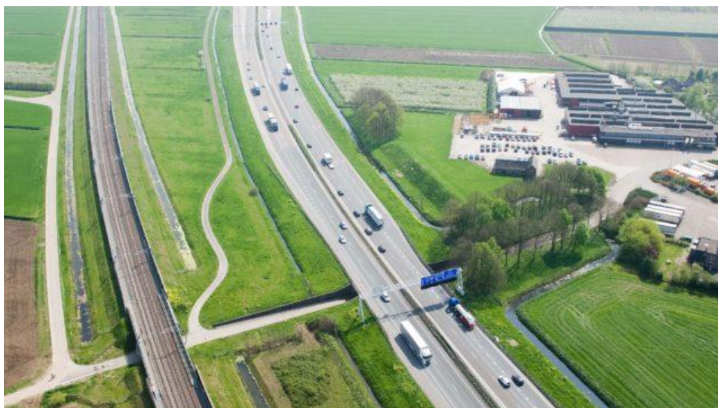
ViA15 (Foto: Joop van Houdt/Rijkswaterstaat)
