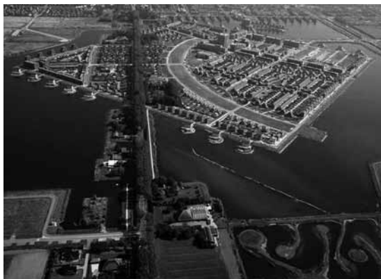
Onder: Stad van de Zon, stadsuitbreiding Heerhugowaard (foto: Jan Tuijp)
