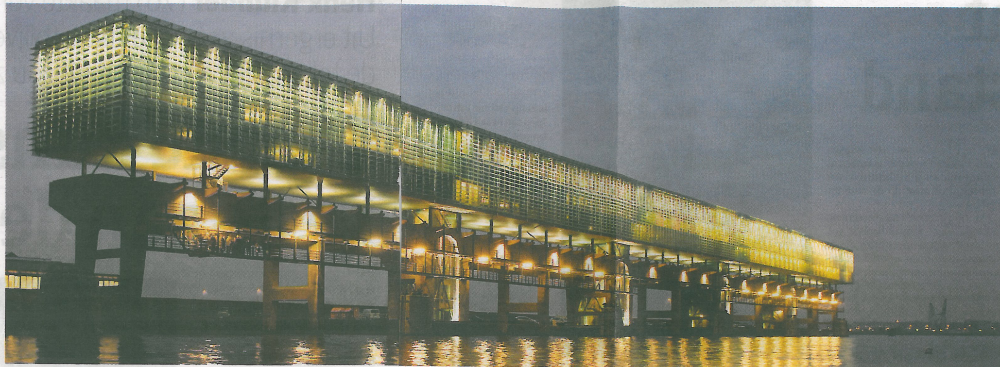
Bedrijfsverzamelgebouw Kraanspoor in Amsterdam. Het is gebouwd op een oude betonnen constructie waarop vroeger havenkranen stonden. Foto: Bram Budel
