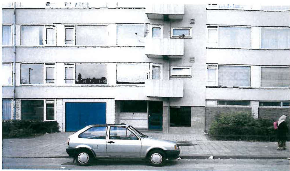
De sloopaantallen blijven aan de lage kant
